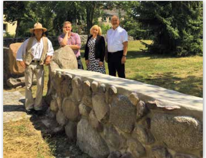
Der instandgesetzte Teil der Kirchenmauer. Im Hintergrund von links: Steinmetz Roland Riesenberg, Pfarrer Steffen Wegener, die Vorsitzender des Gemeindefürsors Bärbel Wunsch und Bürgermeister Ortwin Baier vor dem instandgesetzten Teil der Kirchenmauer
