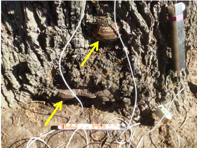
Foto 2: Detail. Pilzfruchtkörper des Lack- porlings (holzzersetzender Pilz).
