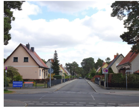
Ursprungsgebäude prägen die Siedlung
