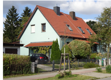
Ruhige Anordnung von Dachfenstern
