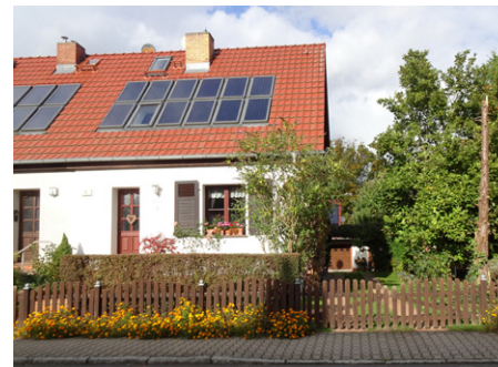
Flächig integrierte Solarmodule
