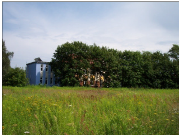
Abbildung 32 – Bereich des Kita-/Schulstandorts
