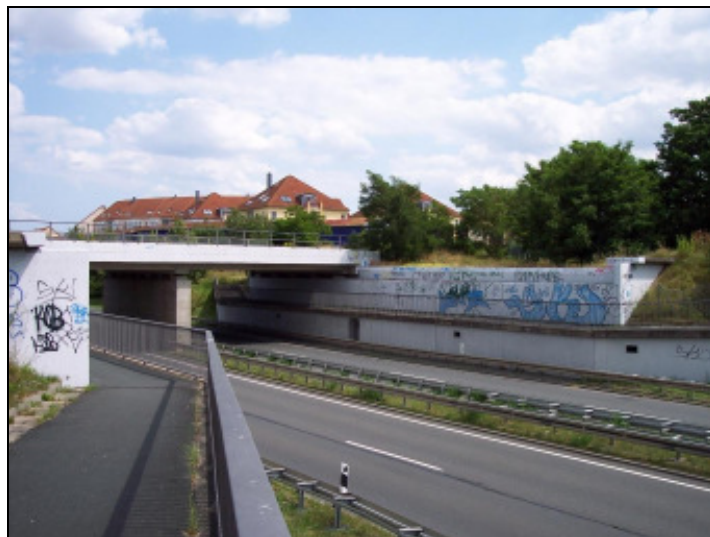
Abbildung 14 – Die Bahnüberführung an der Landesstraße L76
