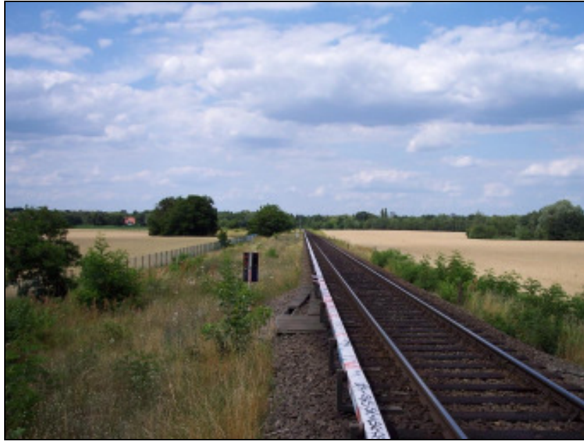
Abbildung 4 – Blick vom Bahnübergang Ziethener Straße nach Norden
