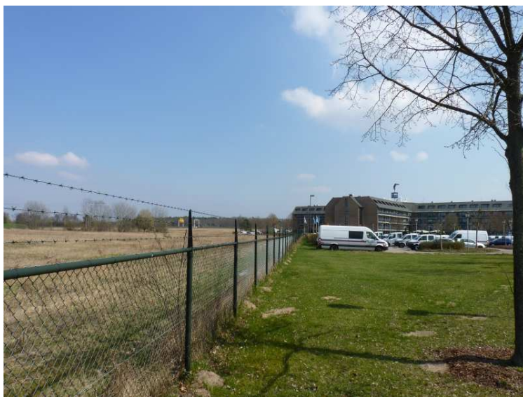
Abb. 6: Stellplatzanlage im Westen mit benachbarter Brachfläche
